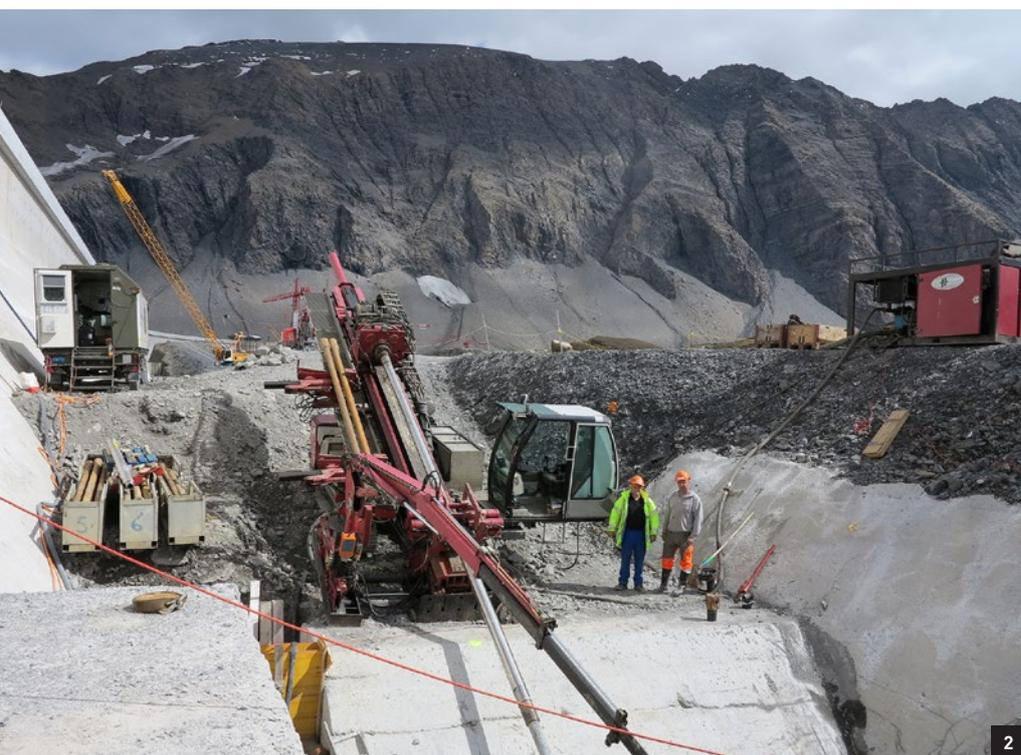
nannten Pushreaming-Verfahren (von oben nach unten) auf 300 und 400 mm aufgeweitet. Für diese Bohrlochaufweitungen wurden sogenannte Holeopener mit Rollenmeisseln eingesetzt. Bedingt durch das stark quarzhaltige Felsgestein war der Verschleiss an Bohrwerkzeugen extrem hoch. Trotzdem konnten diese Arbeiten in wenigen Tagen beendet
